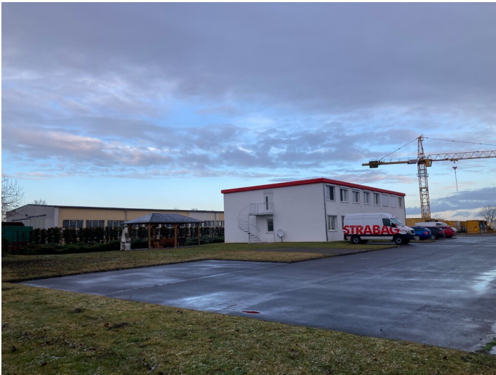
Vulkanisierwerkstatt mit Blick Richtung Nordwest (Gebäude im Hintergrund) Fotograf/Urheber: Isabell Schmock-Wieczorek
