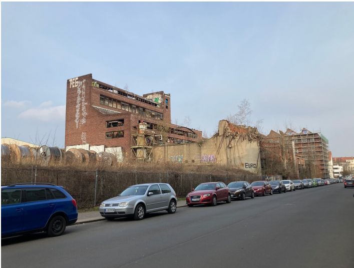
Kesselhaus aus westlicher Richtung Fotograf/Urheber: Isabell Schmock-Wieczorek
