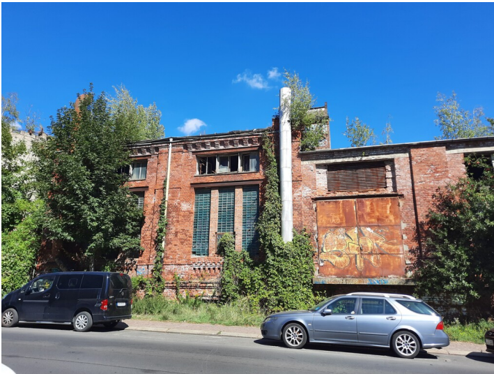
Gebäudestufe zwischen Turbinenhaus Schaltzentrale aus südlicher Richtung Fotograf/Urheber: Isabell Schmock-Wieczorek
