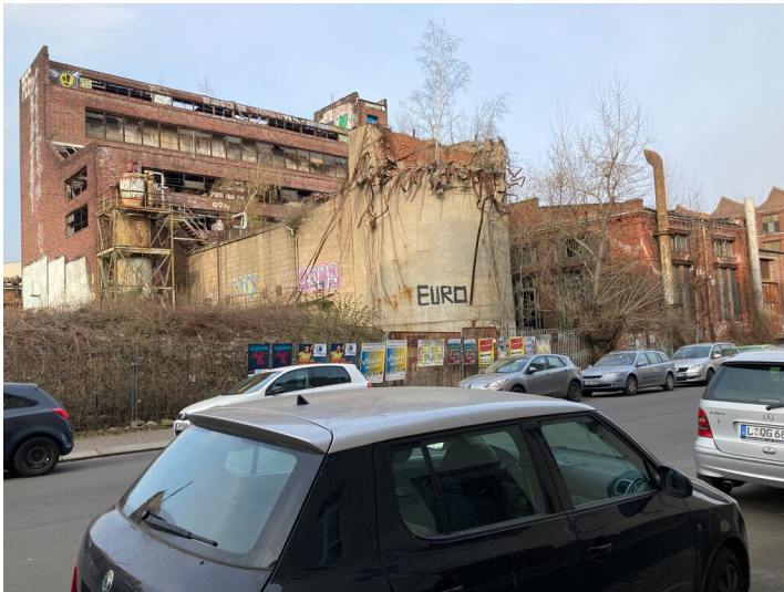
Stumpf des Schornsteins aus südwestlicher Richtung Fotograf/Urheber: Isabell Schmock-Wieczorek
