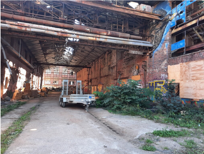
Maschinenhalle I direkt südlich an die Gleishalle anschließend, rechts im Bild Fotograf/Urheber: Isabell Schmock-Wieczorek
