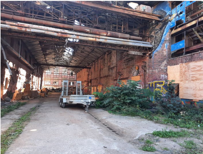
Altes Kesselhaus südlich an die Gleishalle anschließend, hier auf der rechten Bildseite Fotograf/Urheber: Isabell Schmock-Wieczorek
