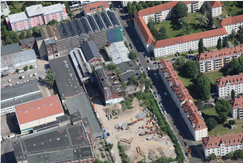
Kraftwerkskomplex aus westlicher Richtung Fotograf/Urheber: Ronald Heynowski
