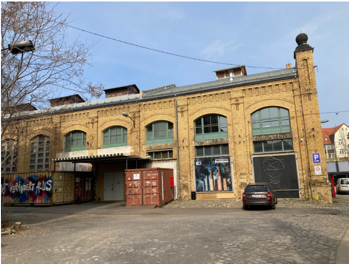
Kraftwerk, westliche Traufseite Fotograf/Urheber: Isabell Schmock-Wieczorek
