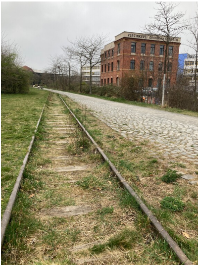
Eisenbahnanlage, Gleisharfe, Stammgleis PVIII oder PV auf Höhe der Konsumzentrale Fotograf/Urheber: Isabell Schmock-Wieczoreck
