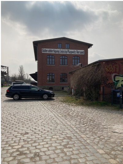
Güterabfertigungsgebäude aus nördlicher Richtung Fotograf/Urheber: Isabell Schmock-Wieczorek
