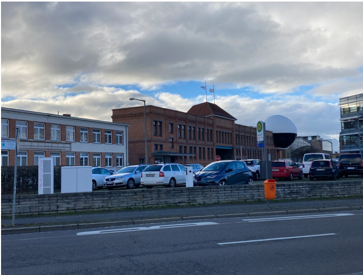
Blick auf das zentrale Fabrikgebäude mit der Niemeyer-Sphere aus nördlicher Richtung Fotograf/Urheber: Isabell Schmock-Wieczorek
