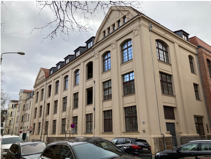
Anlage in der Wilhelm-Sammet-Straße mit Blick nach Südost Fotograf/Urheber: Isabell Schmock-Wieczorek
