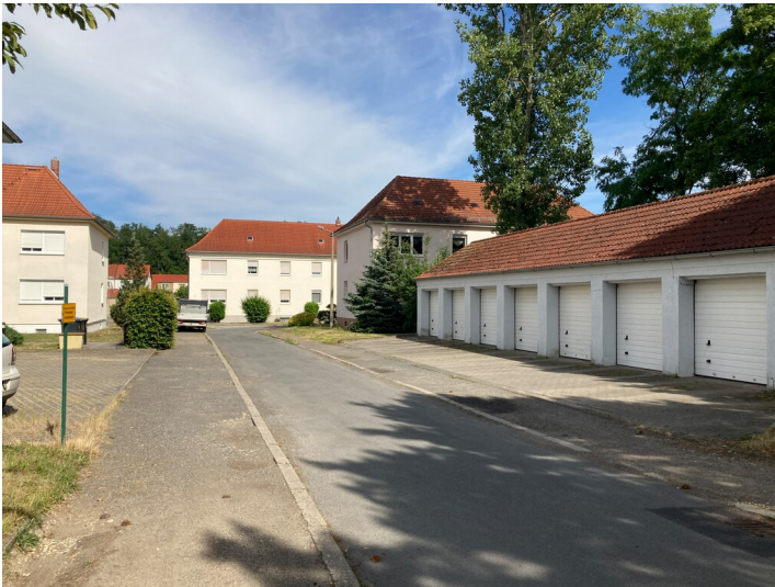
Garagengebäude in der Blumrodaer Straße aus südwestlicher Richtung Fotograf/Urheber: Josephine Dressler
