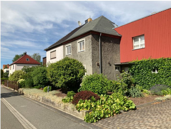
Dopphaus im Kanppenweg Fotograf/Urheber: Josephine Dressler
