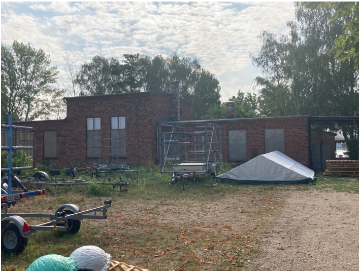
Bargbauanalagenteil, ehemalige Tagesanlagen des Braunkohlentagebaus Kulkwitz Fotograf/Urheber: Isabell Schmock-Wieczorek
