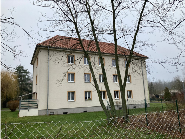
Wohnhaus von der Zwenkauer Straße (aus östlicher Richtung) Fotograf/Urheber: Isabell Schmock-Wieczorek
