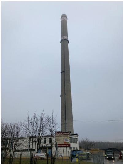
Betonschornstein aus östlicher Richtung Fotograf/Urheber: Isabell Schmock-Wieczorek
