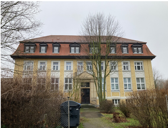
Verwaltungsgebäude der Leipziger Landkraftwerke von der Zwenkauer Straße Fotograf/Urheber: Isabell Schmock-Wieczorek
