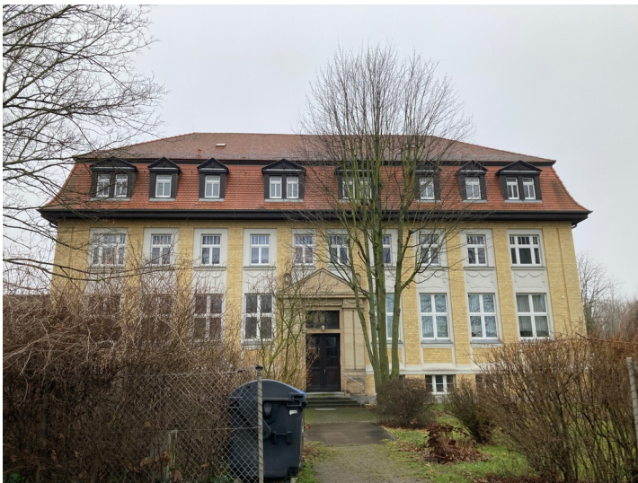
Verwaltungsgebäude der Leipziger Landkraftwerke von der Zwenkauer Straße Fotograf/Urheber: Isabell Schmock-Wieczorek
