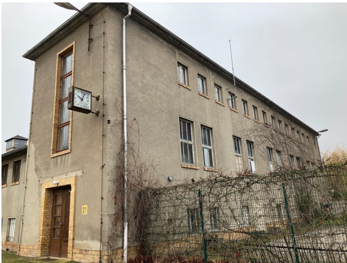
vorderer Teil der Schaltwarte gesehen von Südost Fotograf/Urheber: Isabell Schmock-Wieczorek
