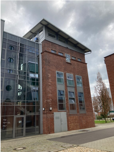
ehem. Wasserturm mit Blick Richtung Südost Fotograf/Urheber: Isabell Schmock-Wieczorek
