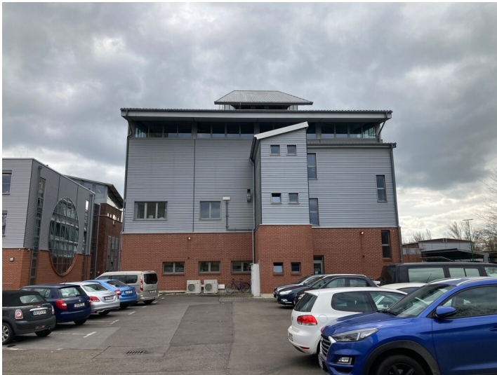
ehem. Fabrikgebäude zur Gaserzeugung aus nördlicher Richtung Fotograf/Urheber: Isabell Schmock-Wieczorek
