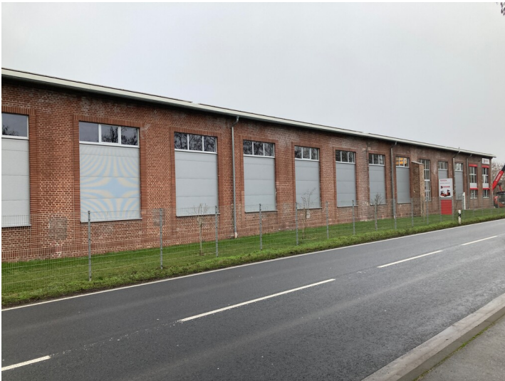
Werkstattgebäude an der Zwenkauer Straße mit Blick Richtung Südost Fotograf/Urheber: Isabell Schmock-Wieczorek
