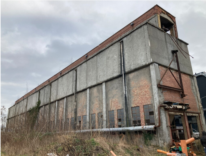
Großraumbunker mit Blick Richtung Südwest Fotograf/Urheber: Isabell Schmock-Wieczorek
