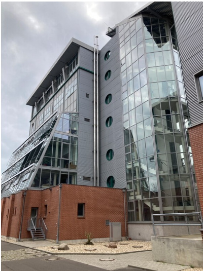
ehem. Ofenhaus des Schwelwerkes mit Blick Richtung Südwest Fotograf/Urheber: Isabell Schmock-Wieczorek
