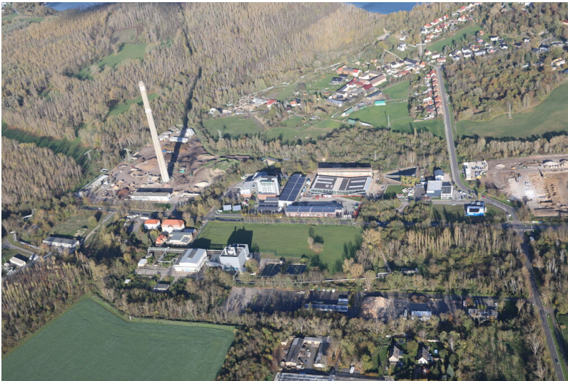
Gelände des ehemaligen Braunkohlenwerkes Kulkwitz von Westen (Luftbildaufnahme) Fotograf/Urheber: Ronald Heynowski
