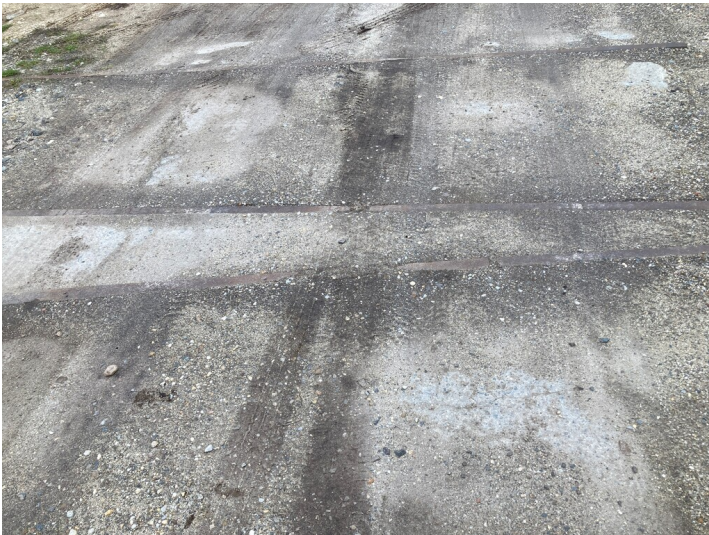
Bahnkörper im Bereich des Werksgeländes des ehemaligen Braunkohlenwerkes Fotograf/Urheber: Isabell Schmock-Wieczorek
