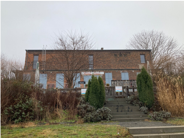
Transformatorstation Westseite (Seeseite) Fotograf/Urheber: Isabell Schmock-Wieczorek
