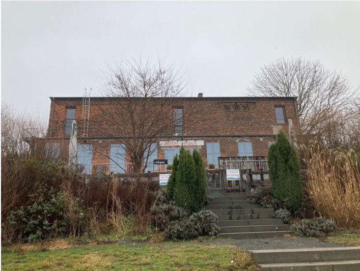
Transformatorstation Westseite (Seeseite) Fotograf/Urheber: Isabell Schmock-Wieczorek
