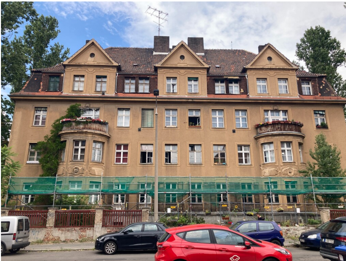
straßenseitige Fassade Fotograf/Urheber: Isabell Schmock-Wieczorek
