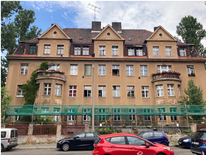
straßenseitige Fassade Fotograf/Urheber: Isabell Schmock-Wieczorek
