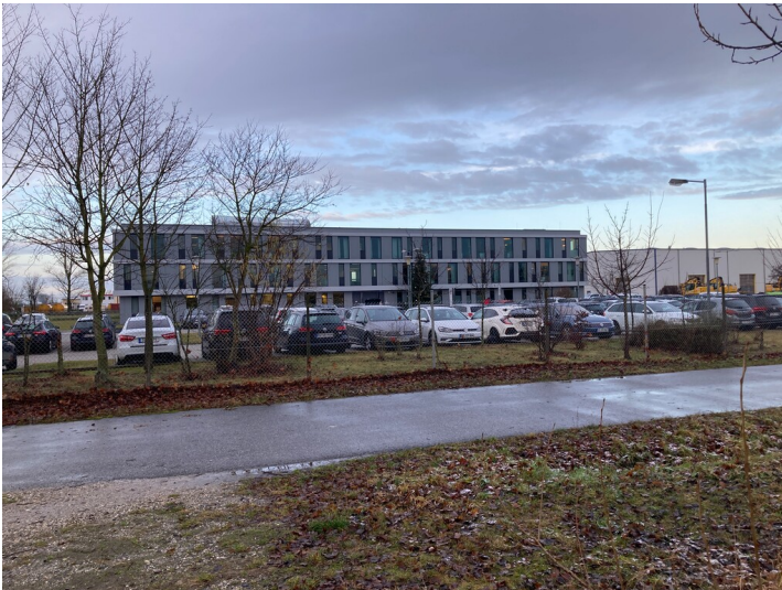
Neubau im Bereich der ehemaligen Tagesanlagen des Tagebaus Breitenfeld aus östlicher Richtung Fotograf/Urheber: Isabell Schmock-Wieczorek
