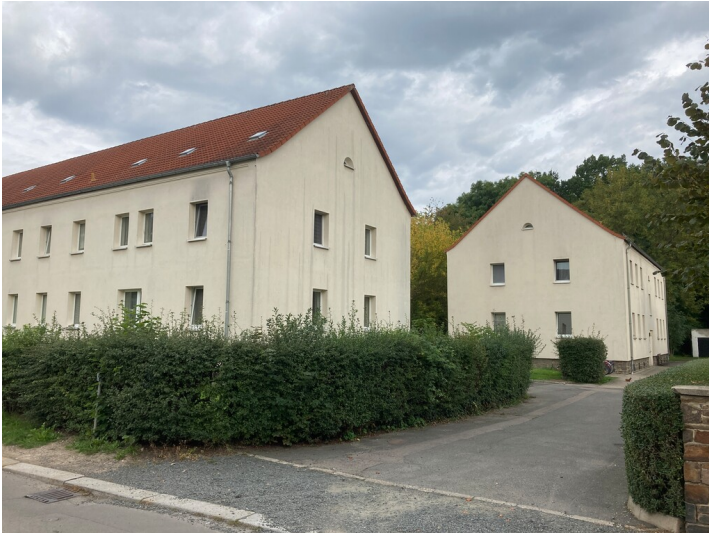
Block 2 und 3 aus südöstlicher Richtung Fotograf/Urheber: Vincent Haburaj
