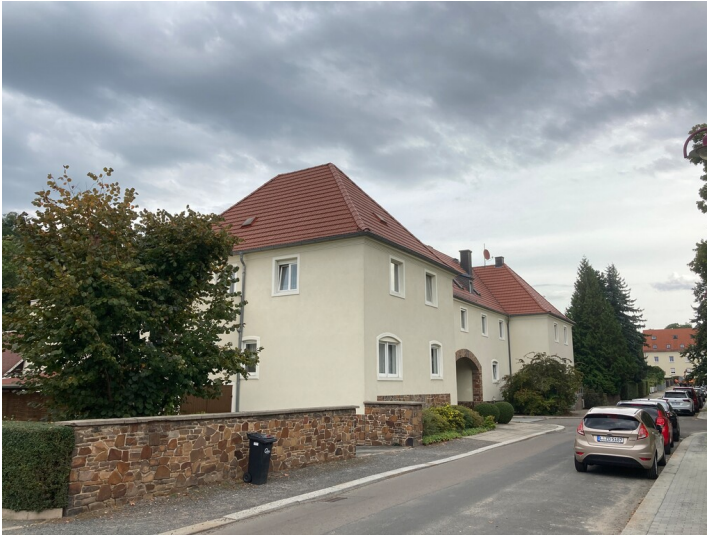
Bäcker- und Fleischergebäude, Wohn- und Geschäftshaus Fotograf/Urheber: Vincent Haburaj
