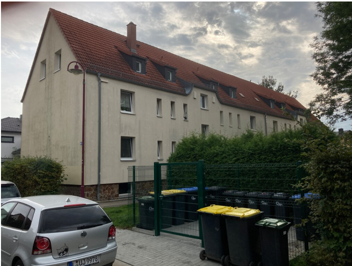
Blick auf ein Siedlungshaus Typ A aus nordwestlicher Richtung Fotograf/Urheber: Vincent Haburaj
