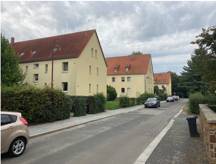
Blick in die Tummelwitzer Str. Richtung in westliche Richtung Fotograf/Urheber: Vincent Haburaj
