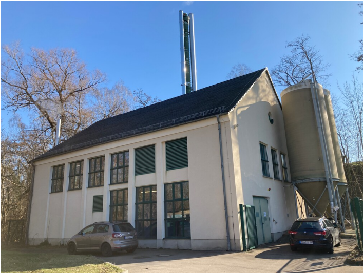
Dampfübergabestation Krankenhaus Borna Fotograf/Urheber: Isabell Schmock-Wieczoreck
