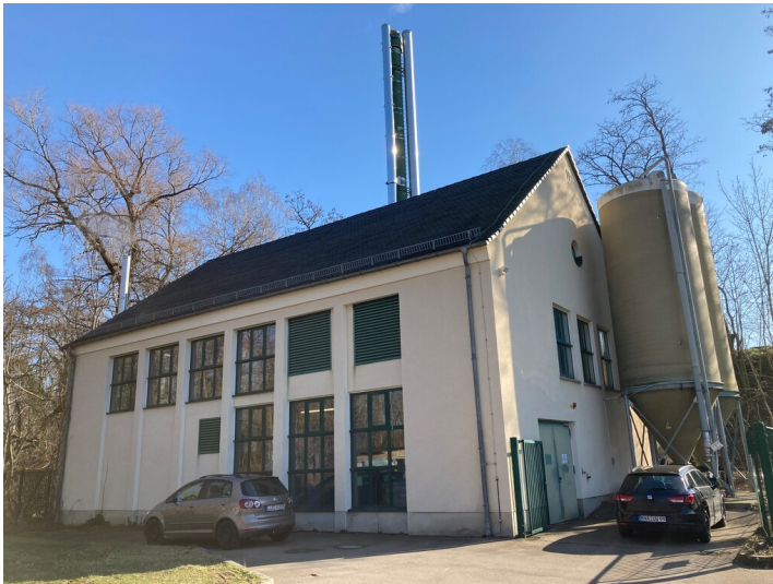
Dampfübergabestation Krankenhaus Borna Fotograf/Urheber: Isabell Schmock-Wieczoreck
