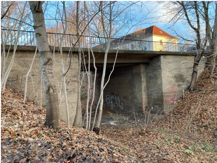
Straßenbrücke über die Witznitzer Kohlenbahntrasse, Röthaer Straße, fotografiert von der Stadionseite Fotograf/Urheber: Isabell Schmock-Wieczorek
