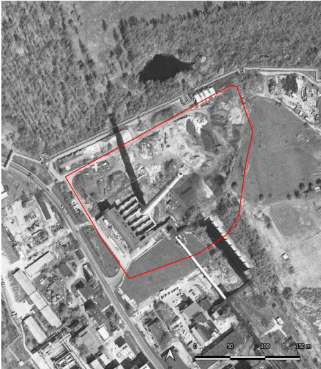
Heizwerk Kulkwitz, Markranstädt (Kartengrundlage: GeoSN, dl-de/by-2-0.: DOP Sachsen. 1998) Fotograf/Urheber: Ullrich Ochs
