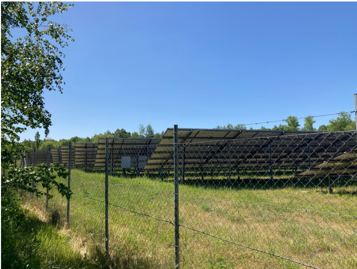
Blick auf das Gelände des Solarkraftwerks Fotograf/Urheber: Isabell Schmock-Wieczorek
