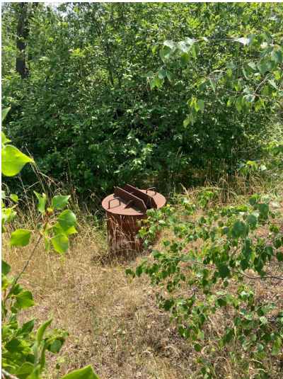
Ein Filterbrunnen des Filterbrunnenriegels, Teil der rekultivierten Landschaft nach dem Braunkohletagebau Fotograf/Urheber: Vincent Haburaj
