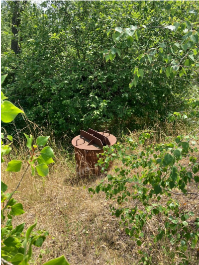
Ein Filterbrunnen des Filterbrunnenriegels, Teil der rekultivierten Landschaft nach dem Braunkohletagebau Fotograf/Urheber: Vincent Haburaj
