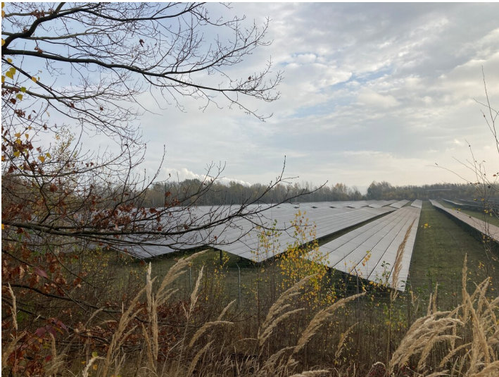
Blick Richtung Osten über das Solarkraftwerk Fotograf/Urheber: Matin Neubacher
