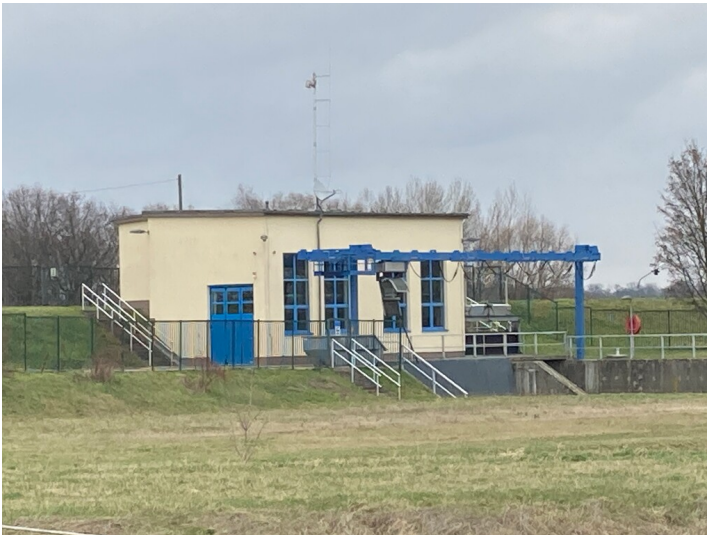
Hebevorrichtung zur Überleitung von Wasser, Blick in Richtung Osten Fotograf/Urheber: Isabell Schmock-Wieczorek
