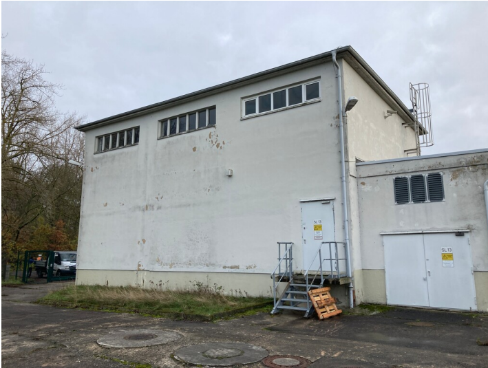
Pumpstation an der Geschiebefalle Kleindalzig, Blick in Richtung Osten Fotograf/Urheber: Nils Schinker
