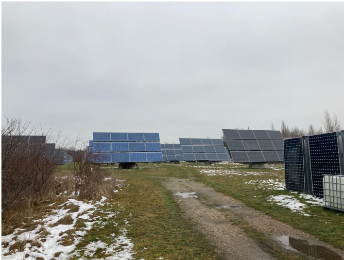
Solkraftwerk auf ehemaligem Brikettfabriksgelände, Blick in Richtung Nordosten Fotograf/Urheber: Vincent Haburaj
