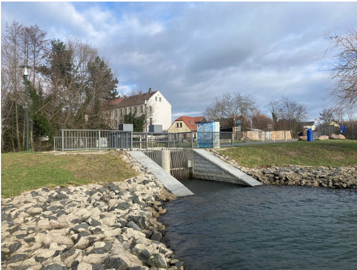
Auslaufbauwerk Markkleeberger See Fotograf/Urheber: Vincent Haburaj
