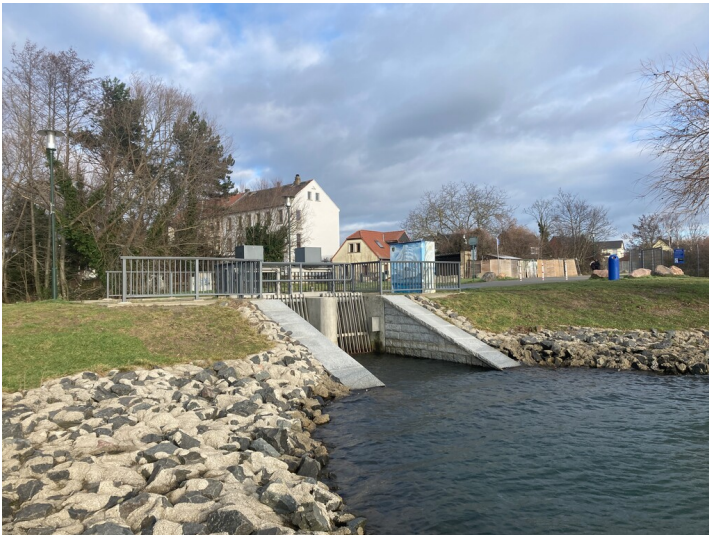
Auslaufbauwerk Markkleeberger See Fotograf/Urheber: Vincent Haburaj
