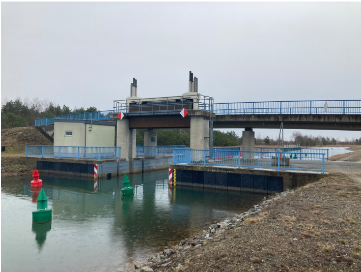
Schiffbarer Überleiter mit Wehr und Schleuse Fotograf/Urheber: Kathrin Krüner
