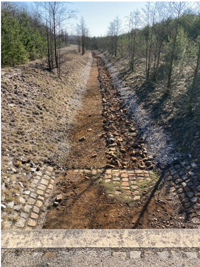
Auslaufbauwerk Lugteich, Kanal Fotograf/Urheber: Tom Pfefferkorn
