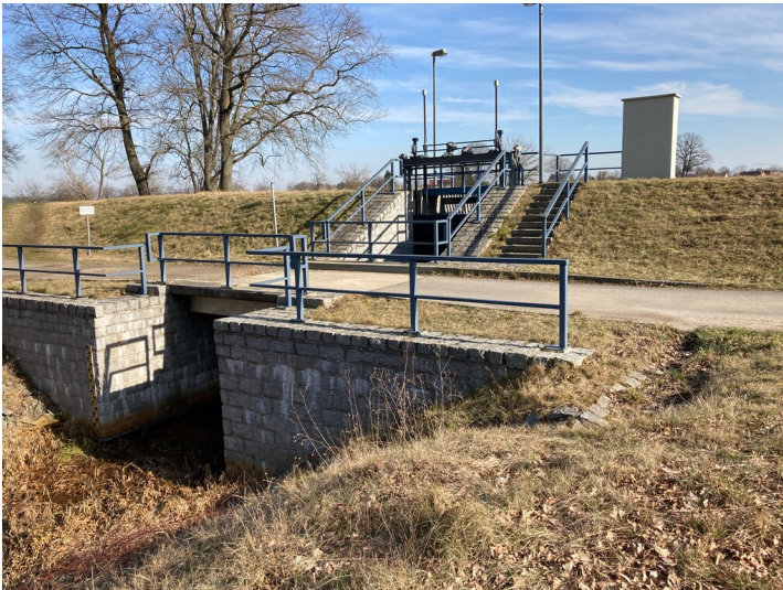
Zulauf Lugteich mit Kanal Fotograf/Urheber: Matin Neubacher
