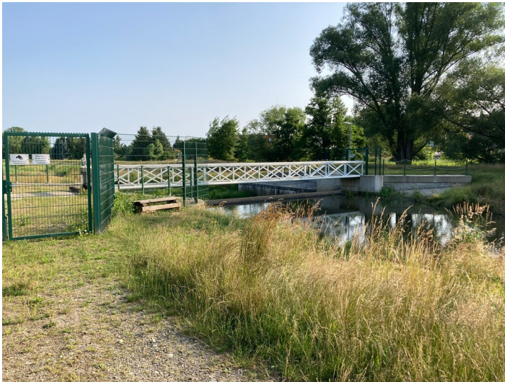
Blick flussabwärts in Richtung der Wehranlage Fotograf/Urheber: Nora Wiedemann
