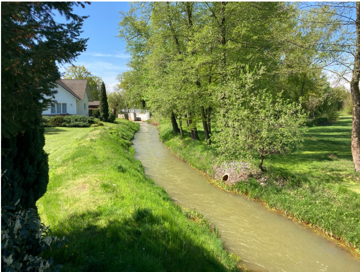
Wasserbauliche Anlage zur Regulierung des Abflussverhaltens, die Anlage ist im Hintergrund erkennbar Fotograf/Urheber: Kathrin Krüner
