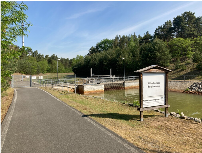
Auslaufbauwerk Bernsteinsee, Blick Richtung Kanal Fotograf/Urheber: Matin Neubacher
