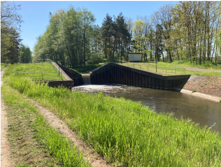
Wasserbauliche Anlage zur Regulierung des Abflussverhaltens, Blick flussaufwärts Fotograf/Urheber: Kathrin Krüner
